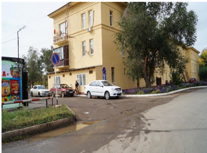
Фото №1 – Подходы к объекту
