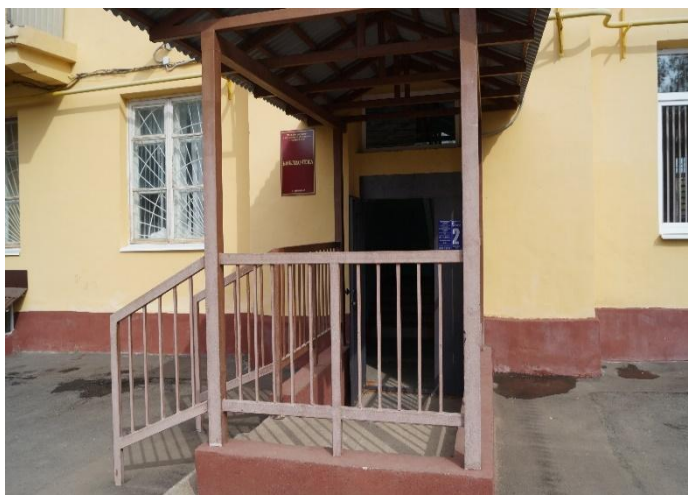
Фото №3 – Входная площадка
