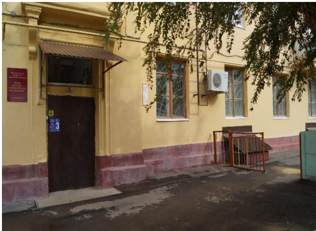
Фото №5 Входная площадка
