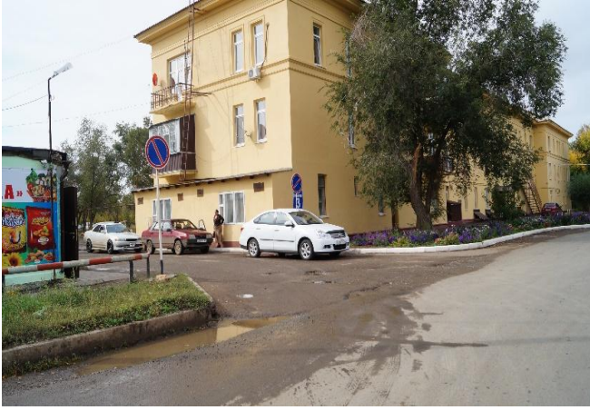
Фото №1 Подходы к объекту
