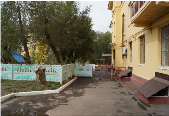
Фото №3 Подходы к объекту
