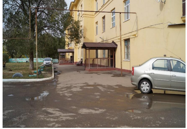
Фото №2 Подходы к объекту
